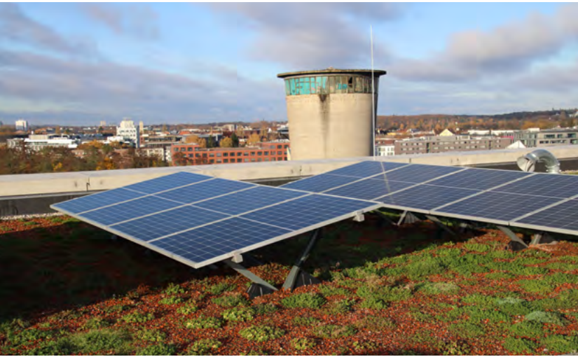
Die Hamburger Umweltbehörde fördert Unternehmen bei der Errichtungen von Gründächern. Foto: BUKEA
