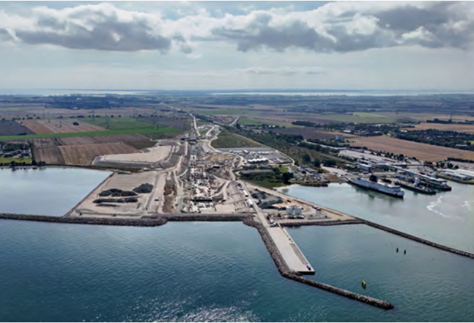
Links: Die Produktionsanlage in Rødbyhavn mit den Becken vor den Fabrikhallen sowie dem großen Arbeitshafen. Im Hintergrund befindet sich das dänische Tunnelportal. Mitte: Die deutsche Tunnelbaustelle bei Puttgarden im August 2025. Rechts: Betonage von Tunnелеlementen in der Fabrik in Rødbyhavn. Fotos: Femern A/S
