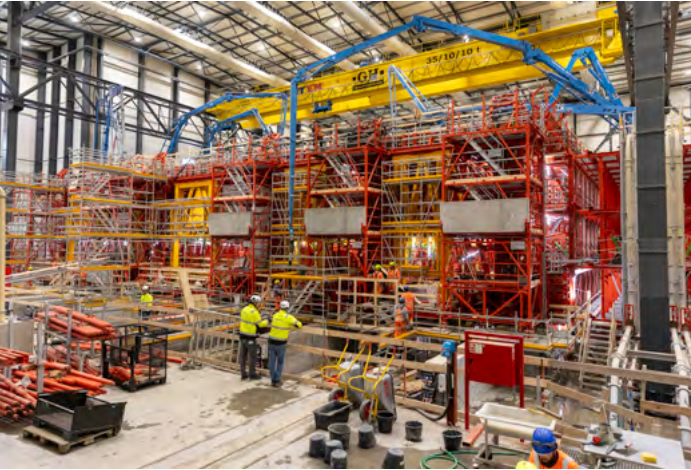
Links: Die Produktionsanlage in Rødbyhavn mit den Becken vor den Fabrikhallen sowie dem großen Arbeitshafen. Im Hintergrund befindet sich das dänische Tunnelportal. Mitte: Die deutsche Tunnelbaustelle bei Puttgarden im August 2025. Rechts: Betonage von Tunnелеlementen in der Fabrik in Rødbyhavn. Fotos: Femern A/S
