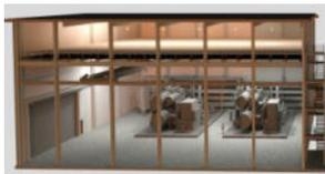
**Nutzung der Wärme des Abwassers mittels 60 MW Abwasser-Großwärmepumpe** auf dem Klärwerksgelände von Hamburg Wasser zur Versorgung von ca. **39.000 Wohneinheiten**.
